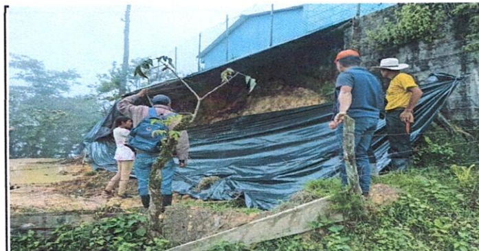
Foto 6: Se observa el estado en la que se encuentra el área de Mejoramiento de muro de contención con concreto lanzado y drenes.
