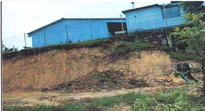
Foto 2: Se observa la altura en la que se encuentra el área de Mejoramiento de muro de contención con concreto lanzado y drenes.
