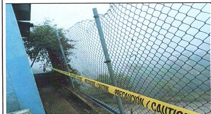
Foto 3: Se observa el estado en la que se encuentra el área de Mejoramiento de muro de contención con concreto lanzado y drenes.
