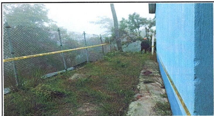
Foto 4: Se observa el estado en la que se encuentra el área de Mejoramiento de muro de contención con concreto lanzado y drenes.
