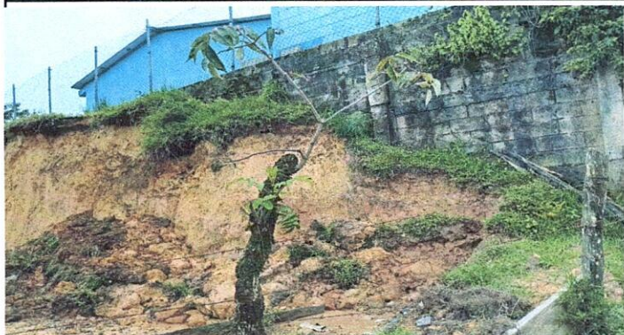
Foto 1: Se observa el estado en la que se encuentra el área de Mejoramiento de muro de contención con concreto lanzado y drenes
